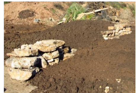
Terre végétale rapportée en butte derrière le muret qui reste apparent et habillage maigre en terre en pied de muret (photos X-AEQUO®)
