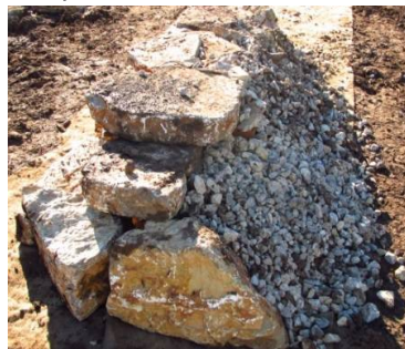
Ballast en face arrière enfouissant les boisseaux, les rondins et les blocs.
