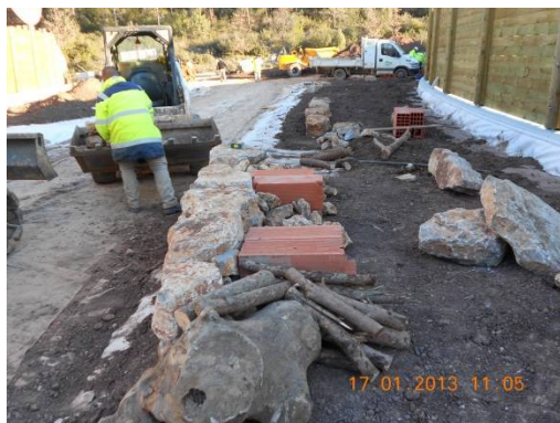
La mise en pratique des éco-restanques ici en contexte calcaire sur l'écopont de Brignoles (photo MILLET Paysage)
