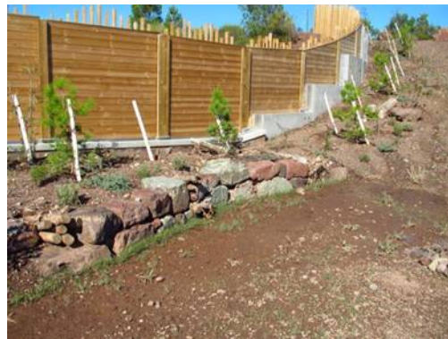
Mise en œuvre avec des matériaux siliceux sur l'écopont de Pignans (photo X-AEQUO®)
