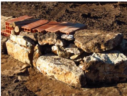
Prototype final validé : pierres sèches en face avant et à l'extrémité de l'andain avec rondins de bois entre les boisseaux de brique
