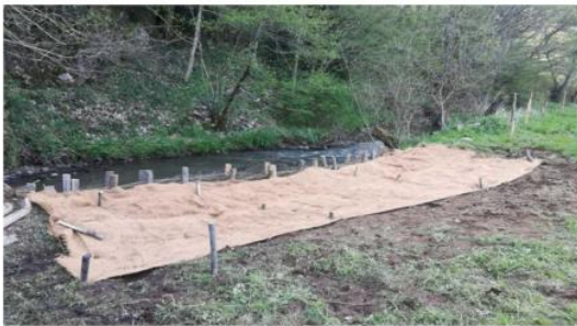
6 : Retaille des pieux et opération terminée !
