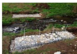
2- Mise en place des fondations (gabions)
