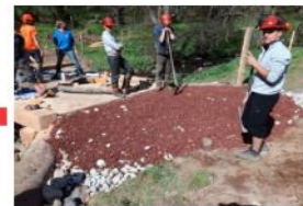
5- Mise à niveau des rampes d'accès
