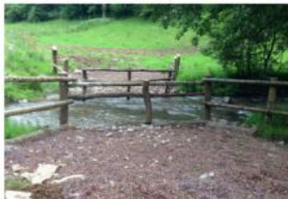
7: Abreuvoir terminé avec pouzzolane et clôture
