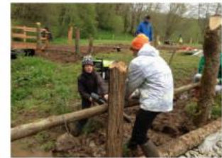
5: Fixation des rambardes
