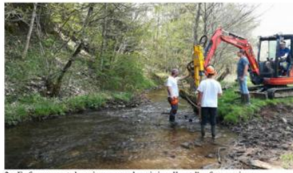
2 : Enfoncement des pieux avec la mini-pelle et l'enfonce-pieu
