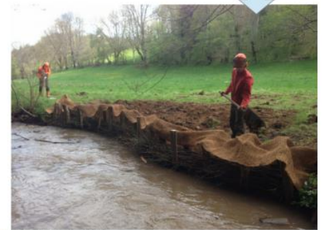
4 : Retalutage de la berge
