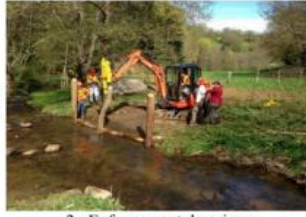
2 : Enfouissement des pieux
