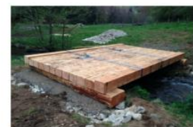
4- Mise en place du tablier
