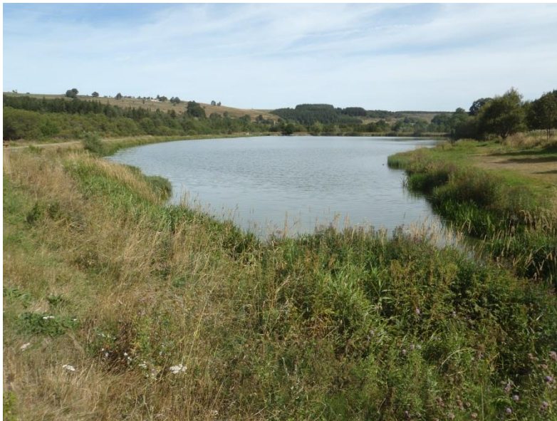
Plan d'eau de Fay-sur-Lignon construit à la place de la rivière Lignon, qui a été détournée (SICALA, 2010)
