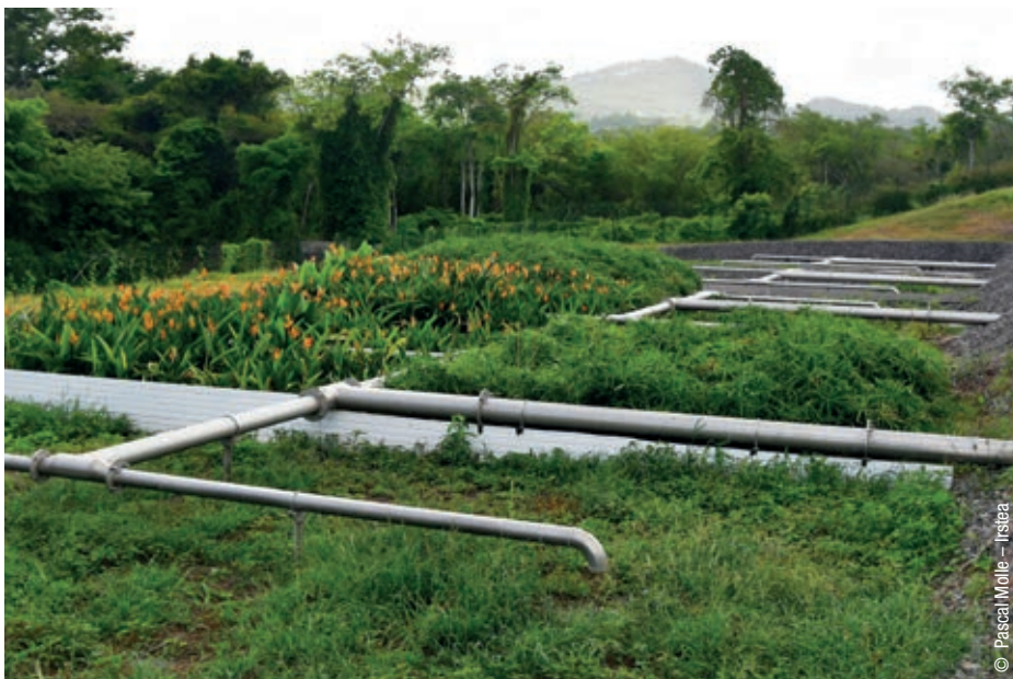
Procédé expérimental de traitement des eaux usées par filtres plantés de végétaux dans le cadre du projet Attentive. Station de Taupinière, Martinique (1 200 équivalents habitants).
