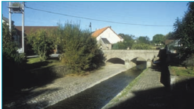
Boudlerbach à Biver : chenal de drainage en milieu urbain.
