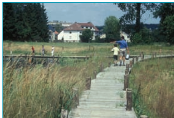
Renaturation au « Brill » à Mamer : les sentiers sur pilotis rendent la zone humide accessible au public. Les sentiers sur pilotis sont particulièrement adaptés pour les aménagements en zone humide car ils respectent la dynamique de la rivière.
