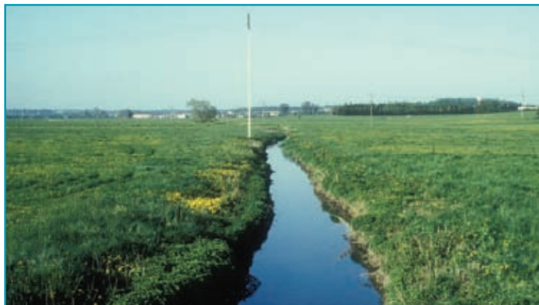
Hesperange : chenalisation en milieu rural visant à limiter les inondations. La structure paysagère n'est plus perceptible et la végétation de la plaine alluviale se limite à des prairies.
