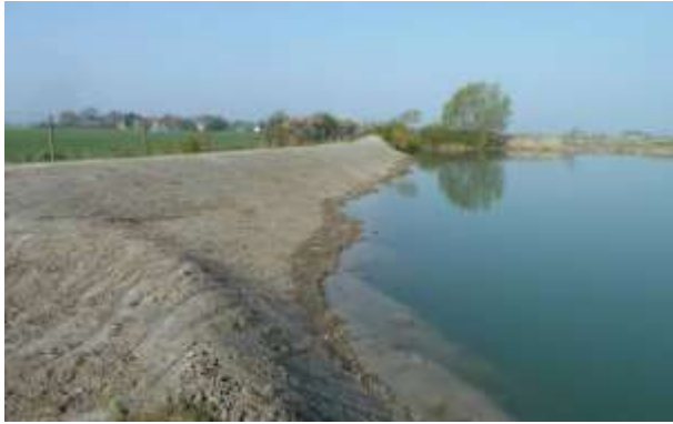
3 - La quasi-totalité des berges fut retravaillée pour créer des pentes douces (photo G.Lemoine)
