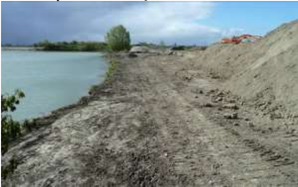
5 - Evacuation des remblais sur la berge ouest du grand étang (photo G.Lemoine)
