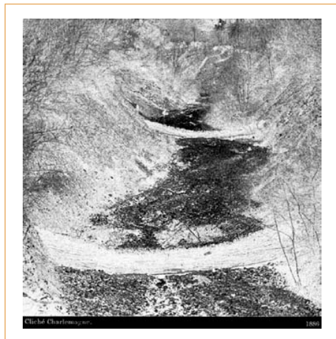
► Figure 4 – Clayonnages dans le torrent de l'Echarina, Isère (Kuss, 1903).
