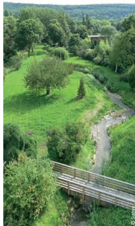
Vue du Moulin Gibeciaux à Gif-sur-Yvette après travaux sur la Mérantaise.
