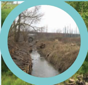
Tressage de saule en pied de berge afin d'éviter toute érosion suite au resserrement des écoulements dû à la mise en œuvre du peigne.
