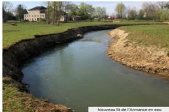
Nouveau lit de l'Armançe en eau
