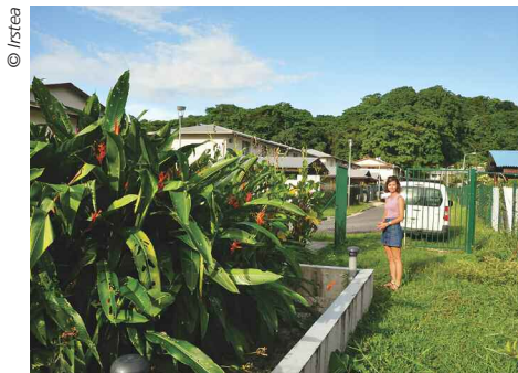
Figure 31. Intégration paysagère d'un FPV dans un lotissement en Guyane.
