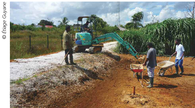
Figure 11. Opération de curage des boues en Guyane sur Bois d'Opale 1. Ces boues peuvent être valorisées en agriculture (Epnac, 2014).
