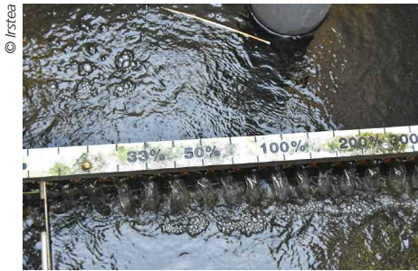
Figure 6. Lame crénelée pour recirculation manuelle.
